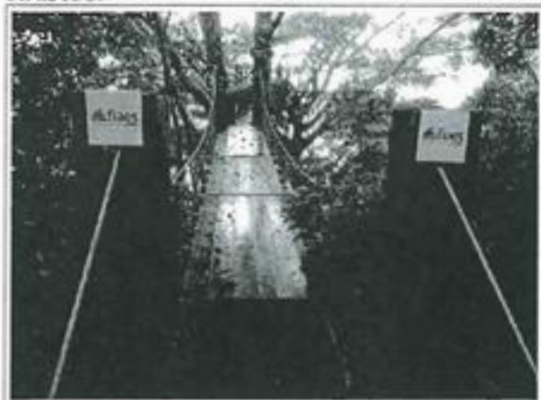
Figura 41: Moderna Plataforma de observación del dosel en Complejo Conchagua. En la foto se da cuenta del mecanismo de financiamiento utilizado. Eso no es bueno para el "branding" del SANP. El público no necesita saber cual mecanismo de financiamiento ha sido utilizado; solo que se trata del sistema nacional de áreas protegidas o "parques nacionales" de El Salvador.
